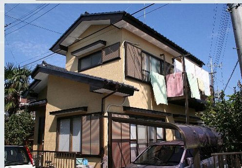
④ 工事完了
