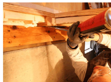
▼気流止め設置
