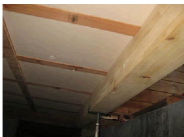
▼断熱材の充填(床下)
