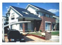
建物の写真 (外観、内部)
