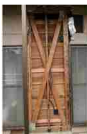
(4) 金物に 羽子板ボルト又は短冊金物(スクリュー釘なし)
